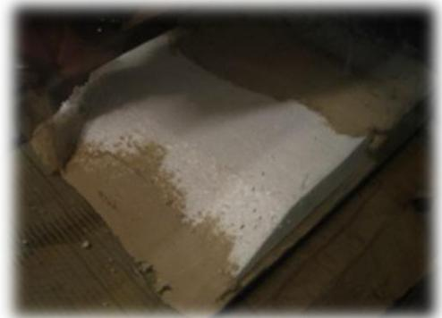
Um Gewicht und Material zu schonen wird Styropor verwendet
