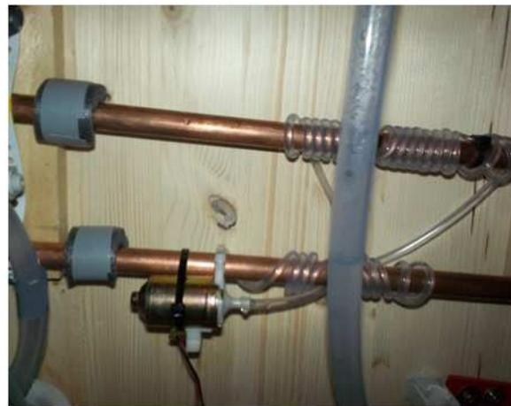
Abbildung 6: Wärmetauscher mit Pumpe
